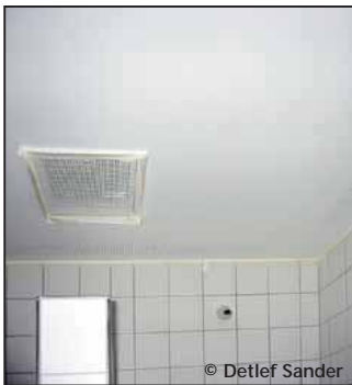
Streichen der Decke mit Nassraumfarbe Painting the ceiling with wet room paint
