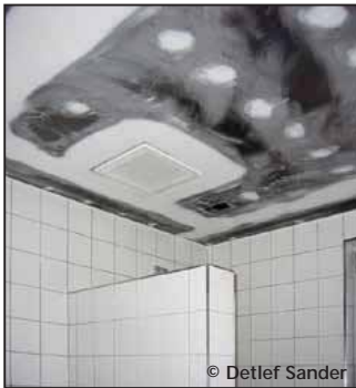
Montage der Platten mit selbstschneidenden Senkkopfschrauben
