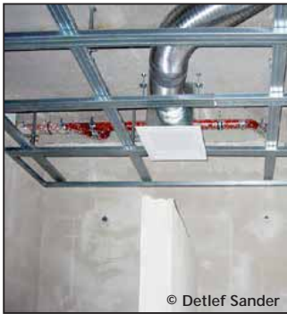
Unterkonstruktion aus CD-Schienen in Konterlattung
